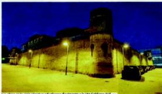
Las obras en la vieja cárcel se adjudicaron finalmente a la Ute Galician ZUT.
